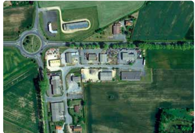
Vue aérienne de la ZA intercommunale Borio Novo à Vielmur-sur-Agout où 6 nouveaux lots de plus de 1000 m 2 sont actuellement commercialisés le long de la D112, à l'Est des entreprises déjà présentes.
