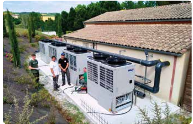
Les pompes à chaleur installées courant juin par l'entreprise CARCELLES à Castres garantiront une température de 26°C minimum.
