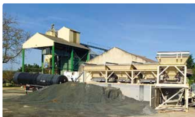
Le poste temporaire de fabrication mis en place sur la commune de Cuq.
