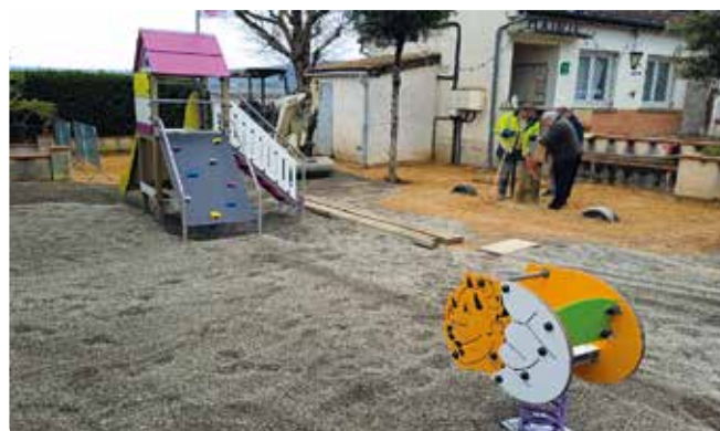
Réalisation d'une aire de jeux pour enfants sur la commune de Prades.
