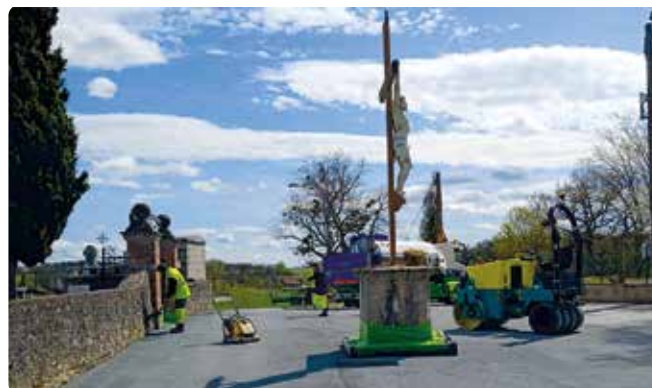
Réfection voirie du parking du cimetière à Brousse.
