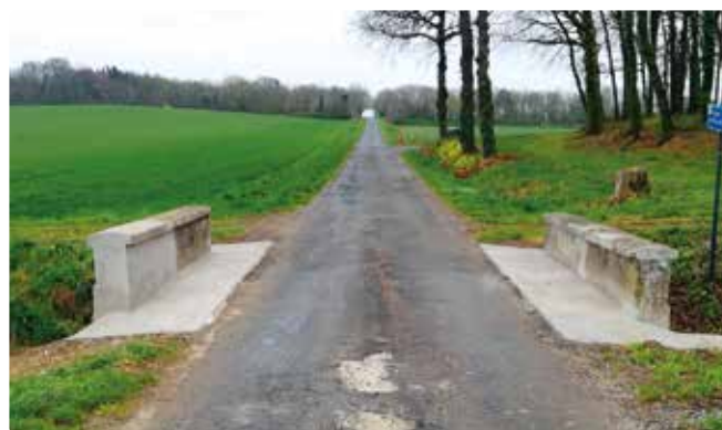
Réhabilitation du pont du bois Louis à Jonquières réalisé en mars 2022.
